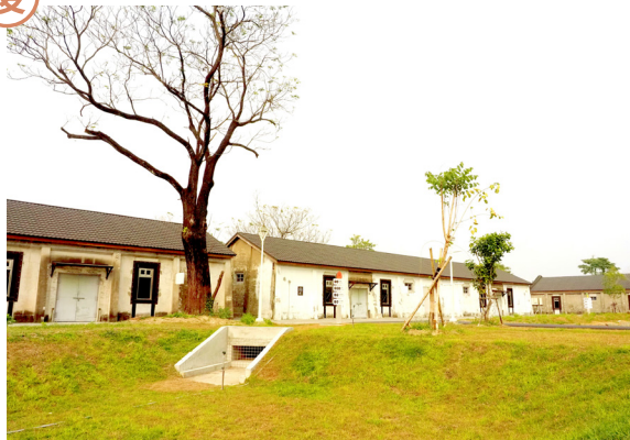
滯洪池的溢流口完成
