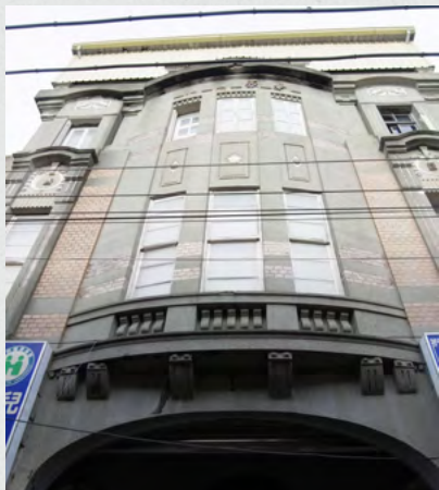
使用洗石子做出石材瓶狀欄杆、牛腿質感。(岡山太原醫院)
