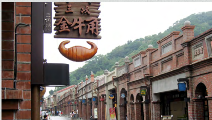
外露管線需配合建築外觀統一設計處理，避免造成建築外觀的凌亂感。
