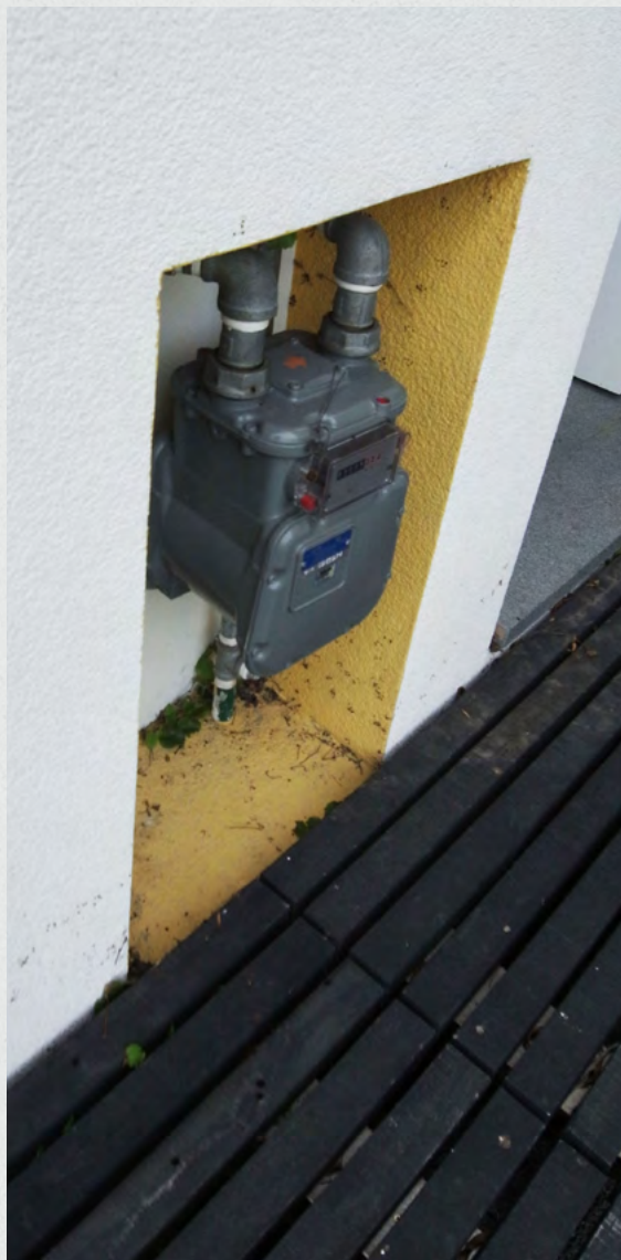
瓦斯管線重新配置時，可設計為內嵌式方法，較不為突兀。
