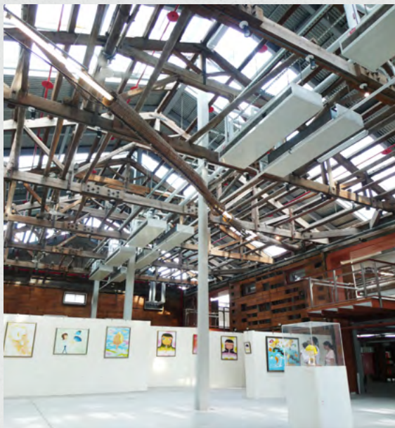
老舊木構造可考慮鋼構補強
