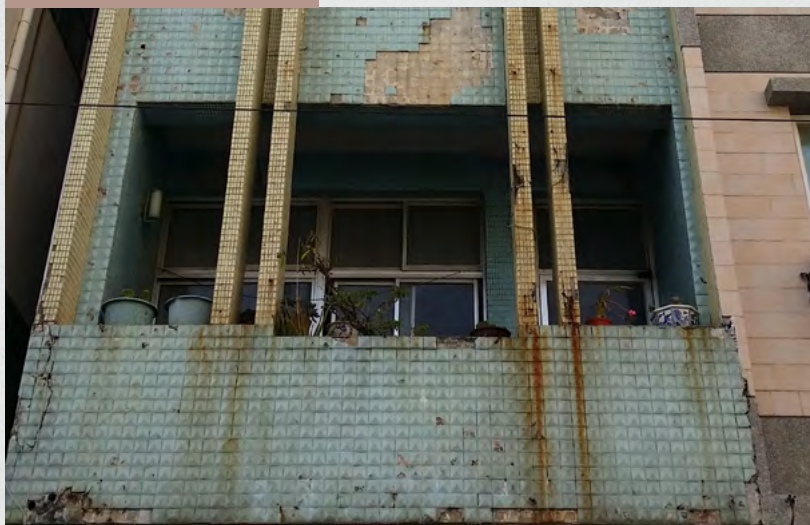
原建築金字塔磚
