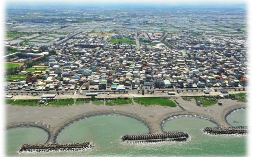
茄荳海岸離岸堤
