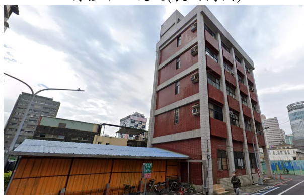
長明派出所現況(長明街側)
