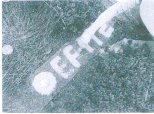
樁標頂端俯視面
