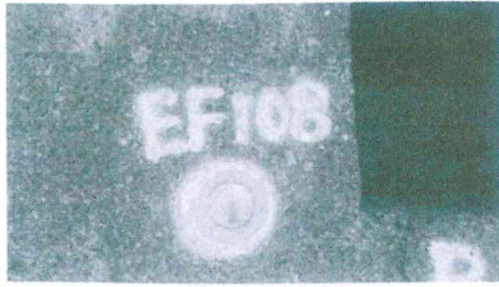
樁標頂端俯視面
