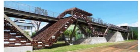
蓮潭城區區古人行橋
