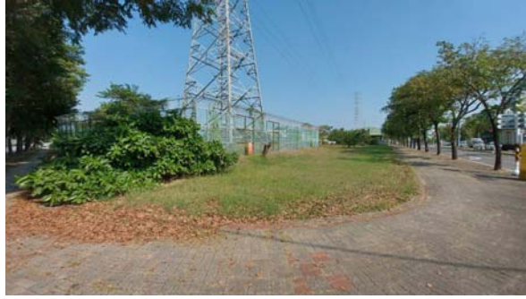
高壓電塔及金屬圍籬(基地西南隅)
