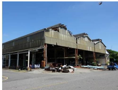
B05 配管工廠
