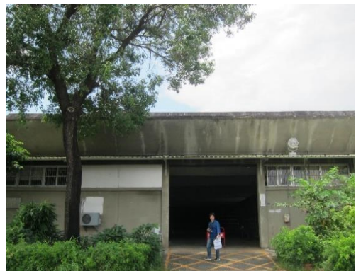
B21 前四號倉庫
