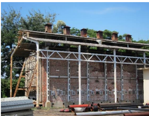
B06 熱處理爐
