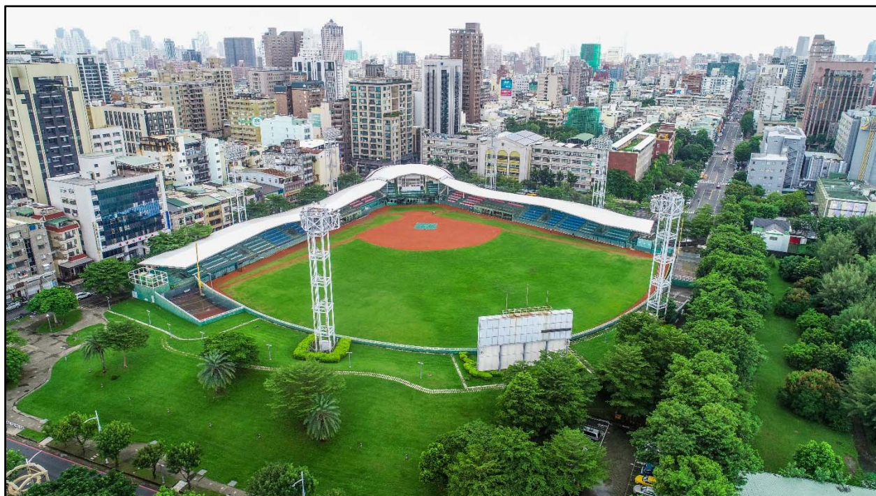
圖3-1-2 立德棒球場建築使用現況
