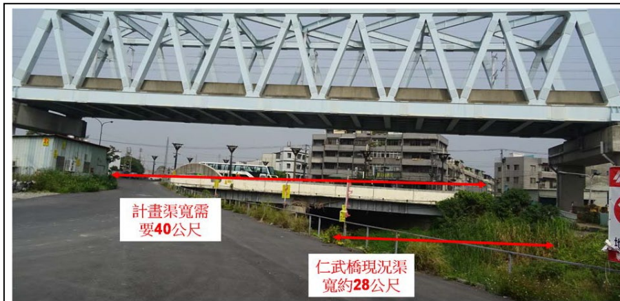
仁武橋現況照片
