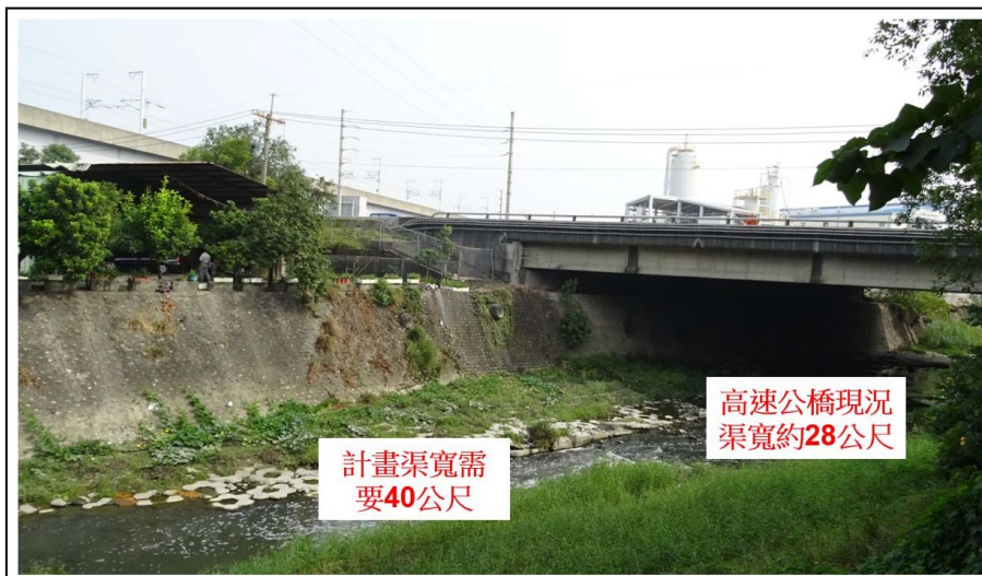
高速公路橋現況照片
