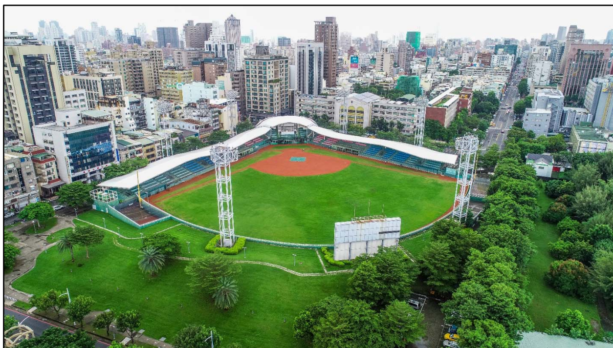
圖3-1-2 立德棒球場建築使用現況
