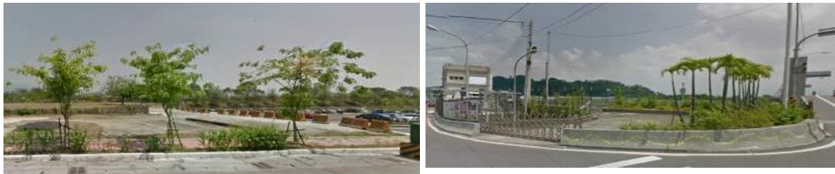
旗山溪岸廣場、停車場及抽水站等設施
