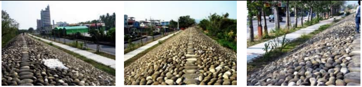
旗山溪岸卵石堤防、自行車及步道
