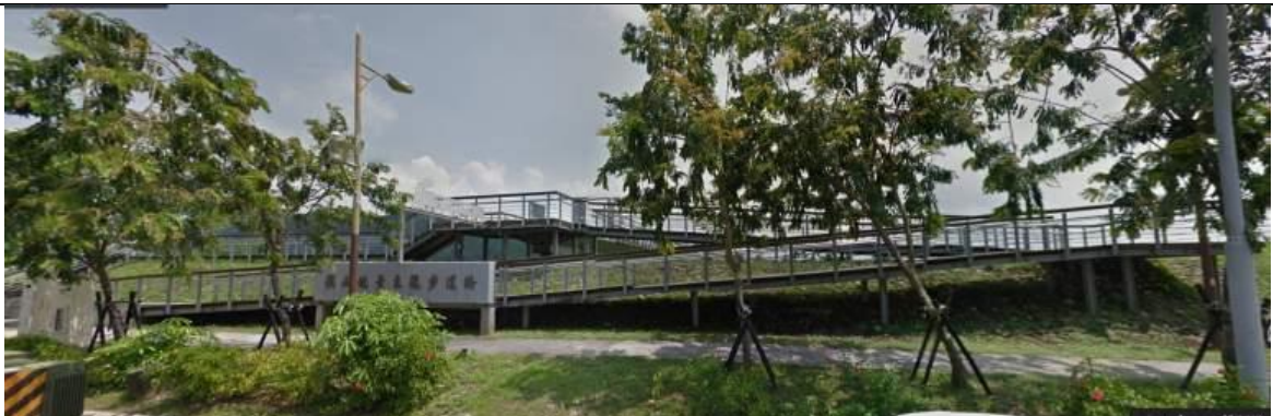
旗山溪地景橋、自行車道及步道
