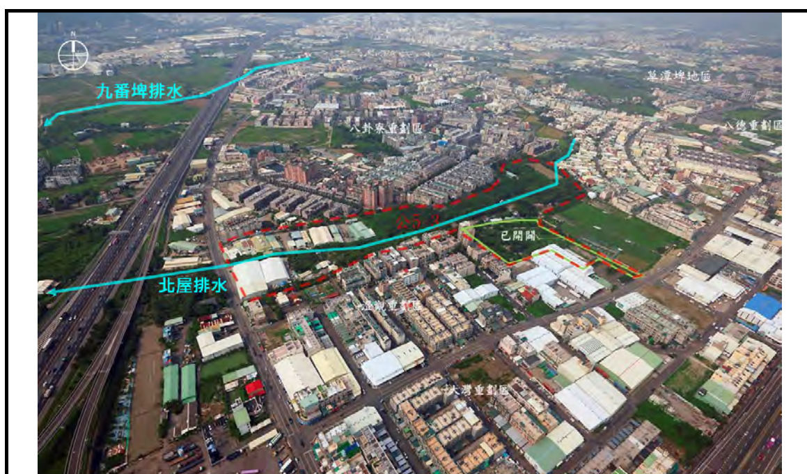
圖 5-14：高速公路易淹水地區現況
