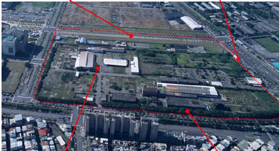
基地西側工廠使用現況
